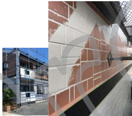
アパート外壁塗装
